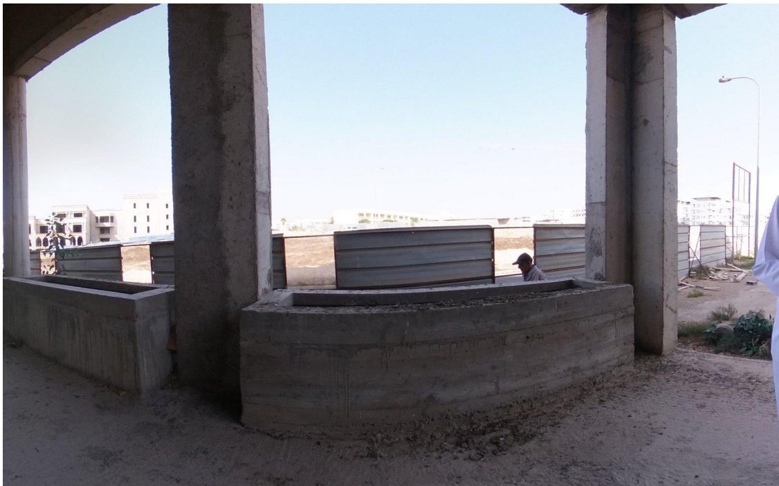
Galerie du rez-de-chaussée avec jardinières en béton (18 septembre 2026)
